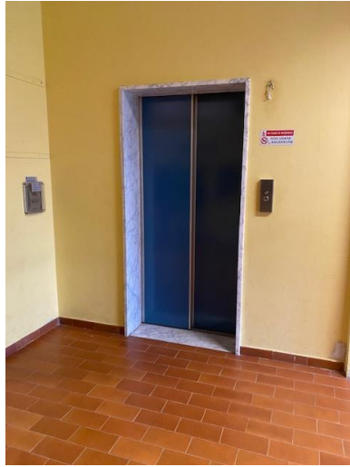
Ascensore in sostituzione
