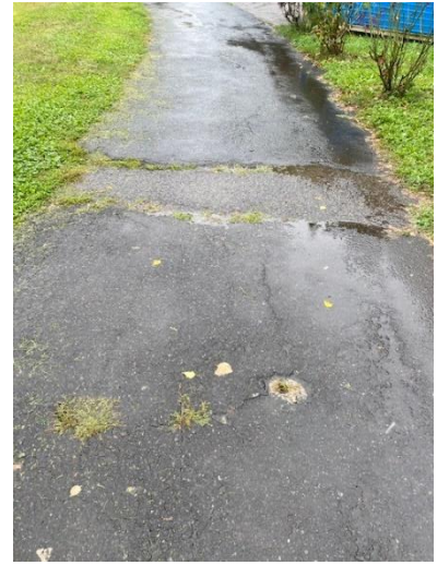
Pavimentazione sconnessa
