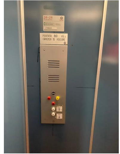
Ascensore in sostituzione
