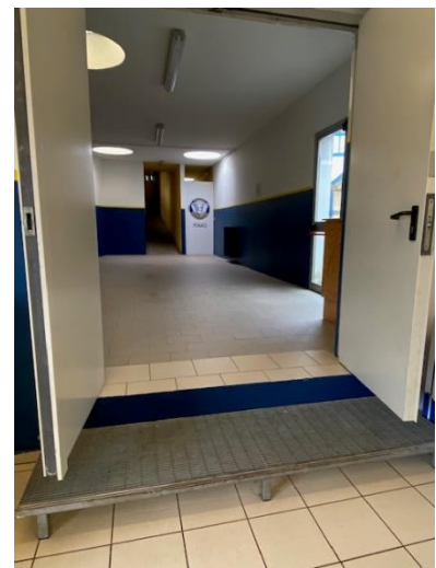
Accesso dal nuovo al vecchio palazzetto
