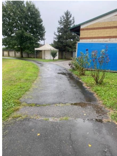
Pavimentazione sconnessa
