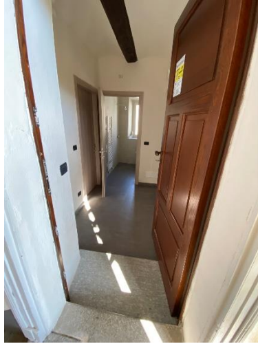
Bagno piano primo
