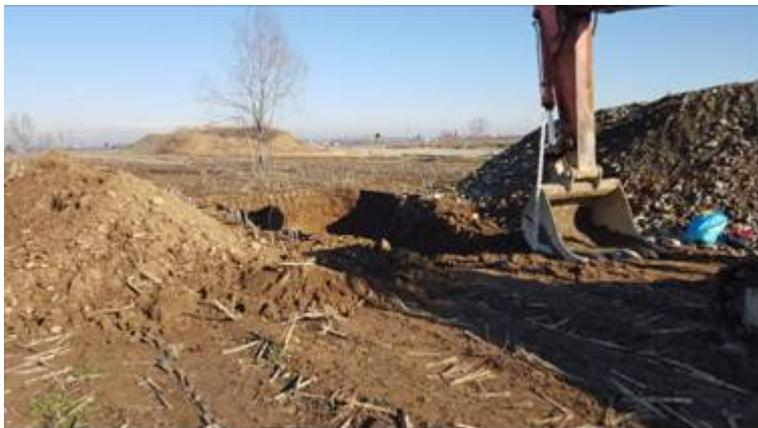
Il Pozzetto Geognostico esplorativo, sviluppato fino a circa 7 m di profondità dal p.c., in corrispondenza dell'area del previsto ampliamento di cava, con dettagli delle pareti che documentano la granulometria ghiaiosa sabbiosa ciottolosa del deposito fluviale interessato dalla coltivazione.
