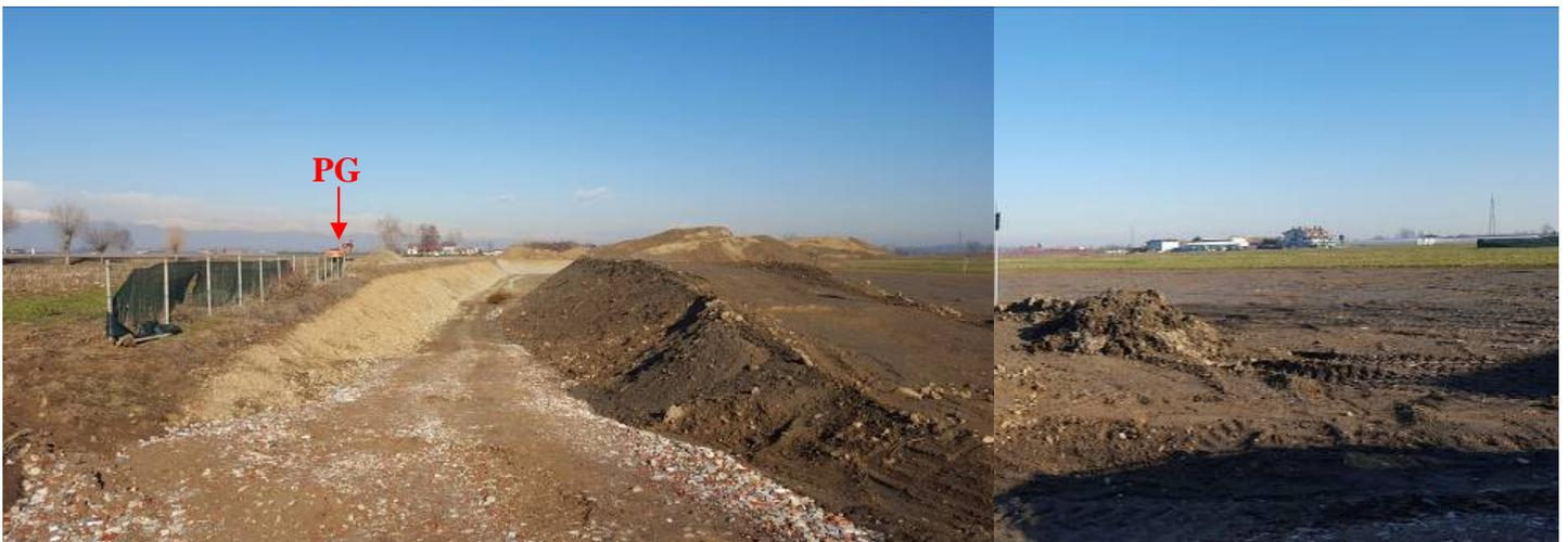
La ripresa panoramica, dal vertice sud ovest, documenta il regolare sviluppo della coltivazione di cava autorizzata; a sinistra la scarpata di scavo lungo il limite ovest, dove è previsto l'ampliamento in progetto e la posizione del Pozzetto Geognostico (PG) eseguito.
