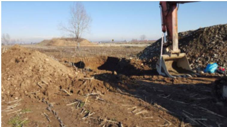
Il Pozzetto Geognostico esplorativo, sviluppato fino a circa 7 m di profondità dal p.c., in corrispondenza dell'area del previsto ampliamento di cava, con dettagli delle pareti che documentano la granulometria ghiaiosa sabbiosa ciottolosa del deposito fluviale interessato dalla coltivazione.
