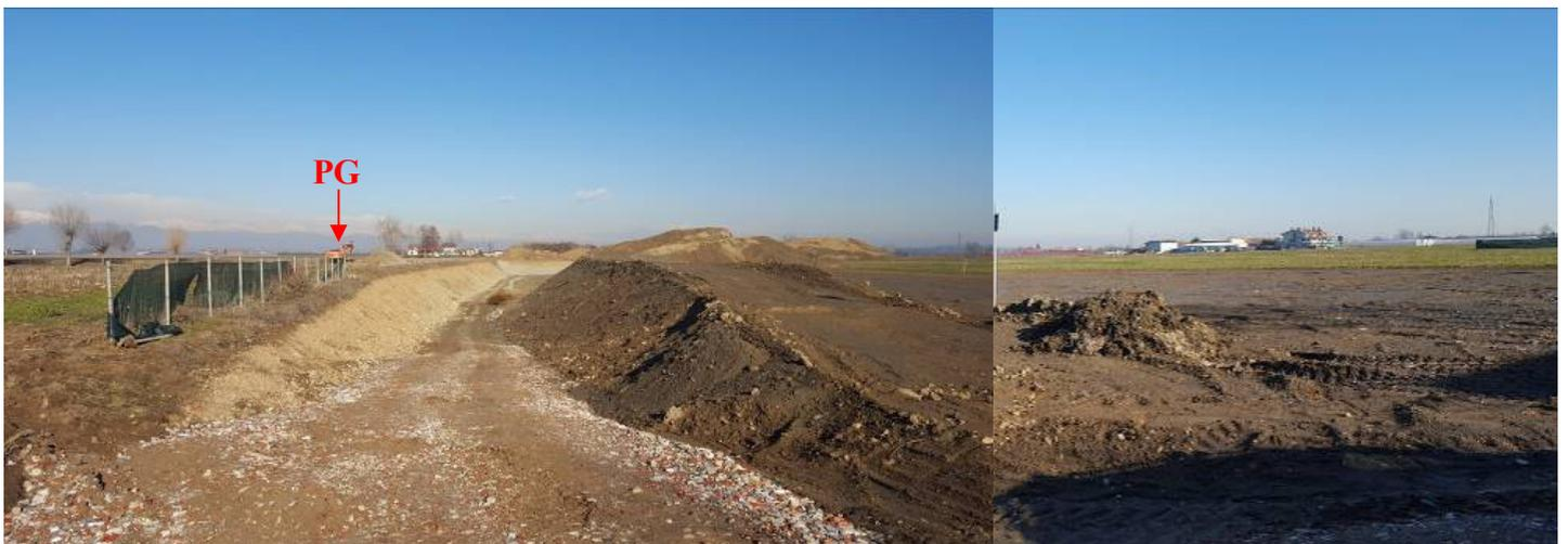
La ripresa panoramica, dal vertice sud ovest, documenta il regolare sviluppo della coltivazione di cava autorizzata; a sinistra la scarpata di scavo lungo il limite ovest, dove è previsto l'ampliamento in progetto e la posizione del Pozzetto Geonostico (PG) eseguito.
