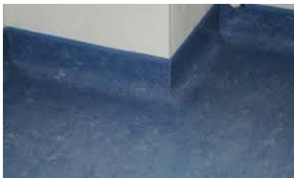
Fig. 8 – particolare sguscia linoleum
