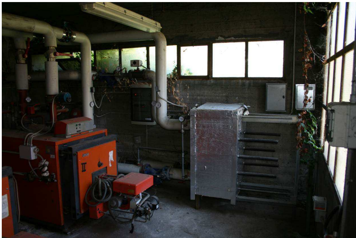
Fotografia 1 – Scambiatore del teleriscaldamento in centrale termica
